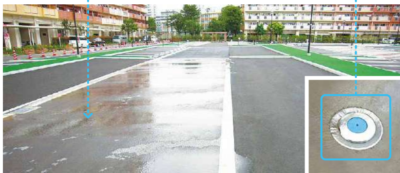
兵庫県UR都市再生機構現場
